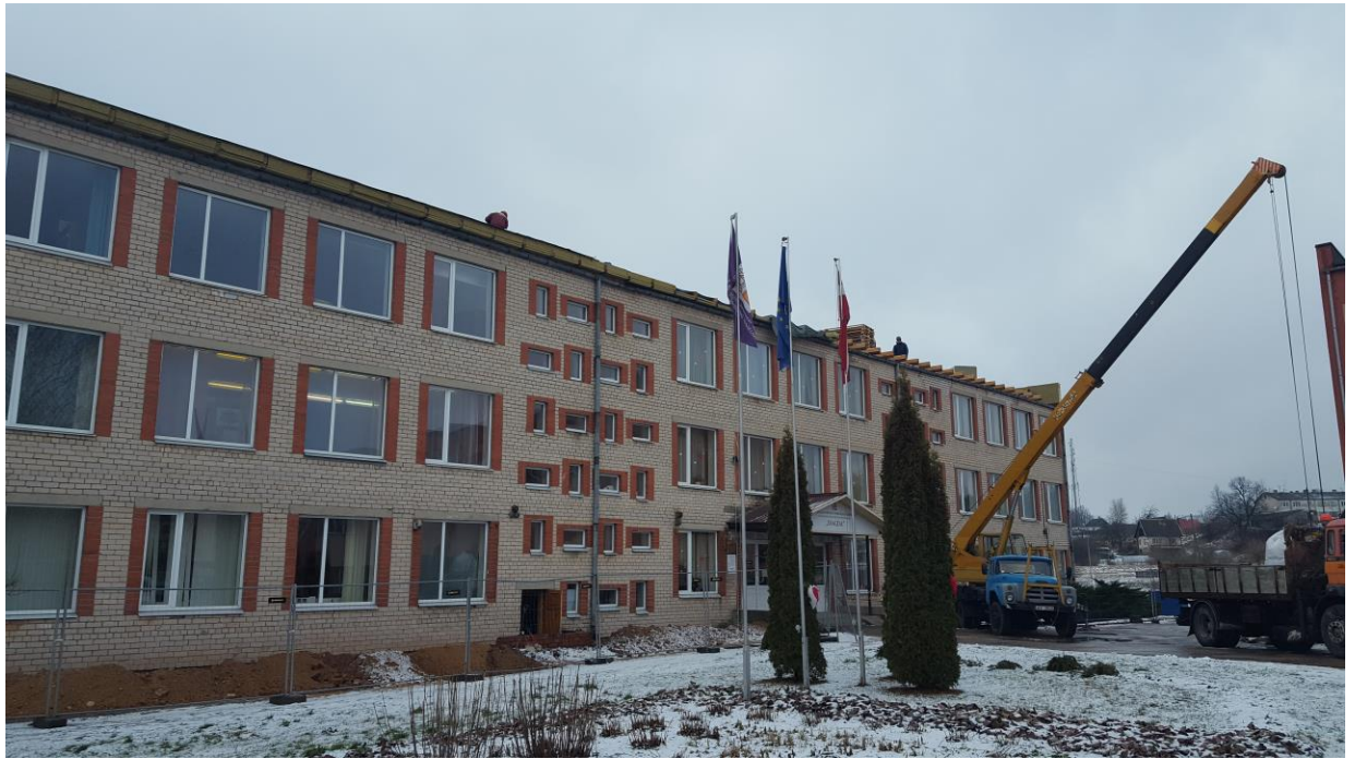
Administratīvās ēkas fasāde 2020.gada februārī
